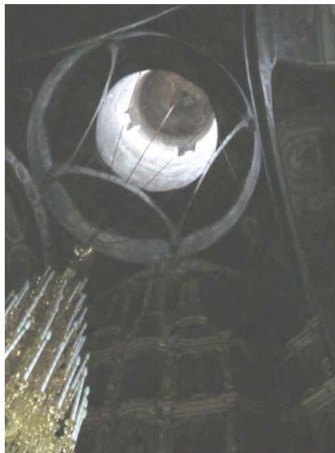
Boltă moldovenească. Biserica Mănăstirii Bistrița, vedere din interior, mijl. sec. XVI
